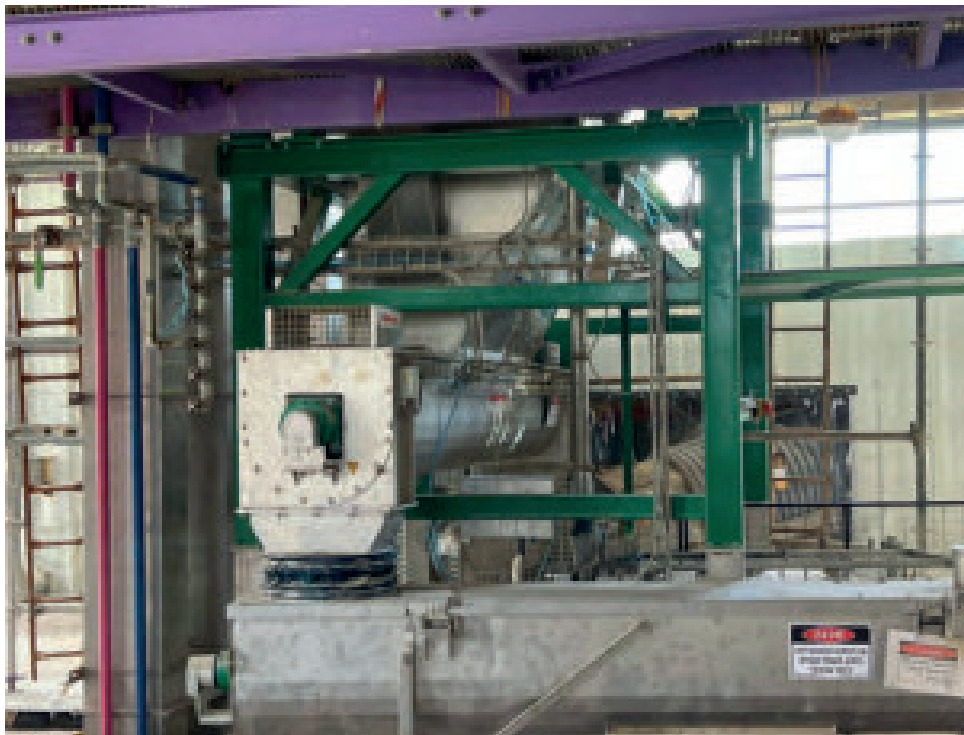
Afb. 2 Bufferhopper met transport naar opzakkers
