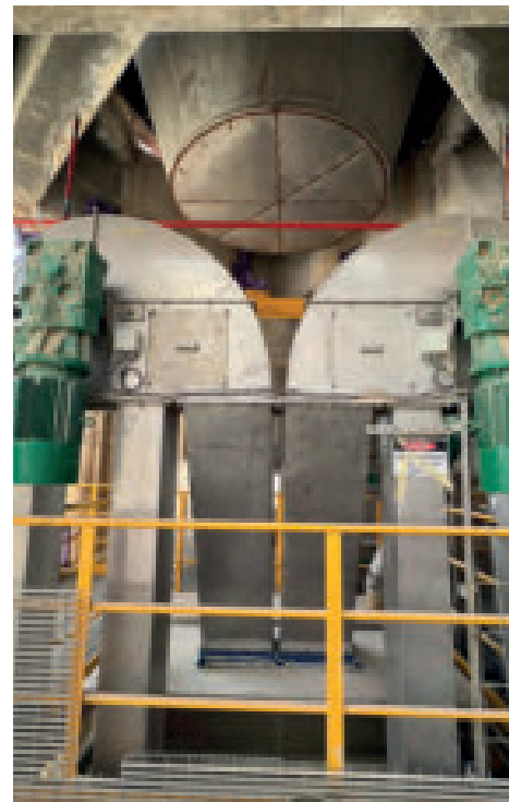
Afb. 3 Dubbele elevator naar ontvangstrechter
