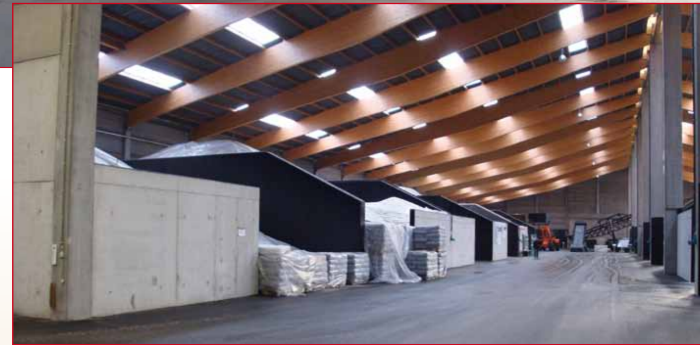
De nieuwe bedrijfshal van Pillaert Meststoffen NV meet 60 m x 120 meter. De hoogte van de nok is 16 meter. De hoogte van de hal is nodig voor het lossen van bulkkippen en voor opslag tot acht meter hoog
