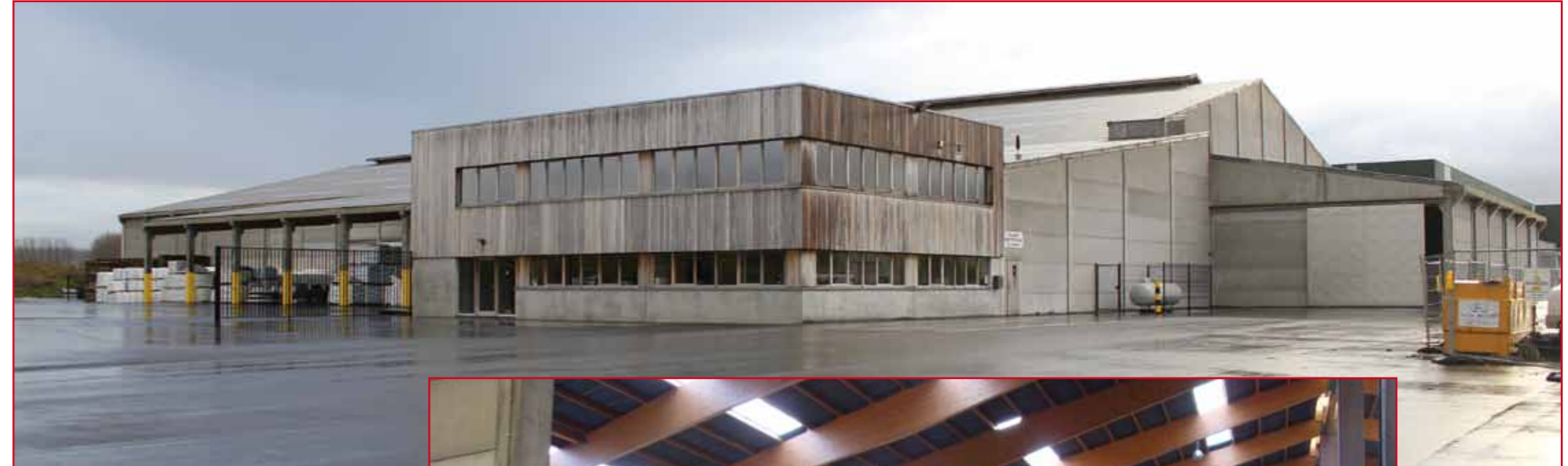
De nieuwe, enig overgebleven locatie van Pillaert is aan het Scheldekanaal, een belangrijke aanvoerweg van minerale meststoffen via de haven van Gent. Vanuit het schip gaat het stortgoed met kippers naar de opslaghal. Dat gebeurt via de weegbrug voor bij het kantoor, die dient voor de boekhouding van binnenkomende en uitgaande leveringen
